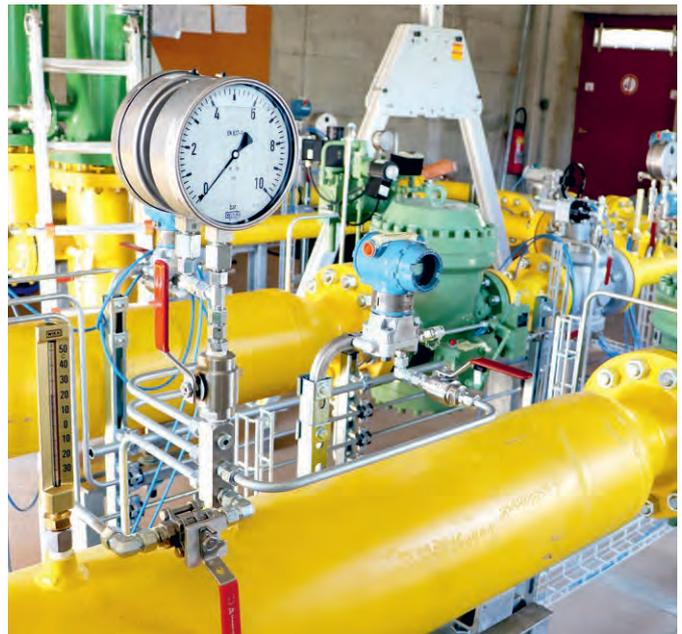
Rénovation d'un poste de détente et de comptage (PDC) à Cossonay, permettant d'augmenter le débit de gaz naturel sur le réseau de Cosvegaz SA.
