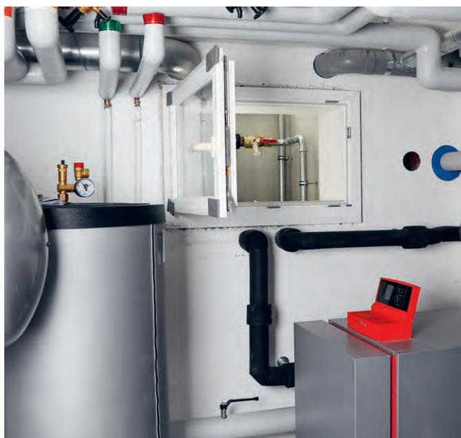
Réalisation d'une installation de chauffage incluant une pompe à chaleur avec sondes géothermiques dans une villa, à Jouxpens-Mézery.
