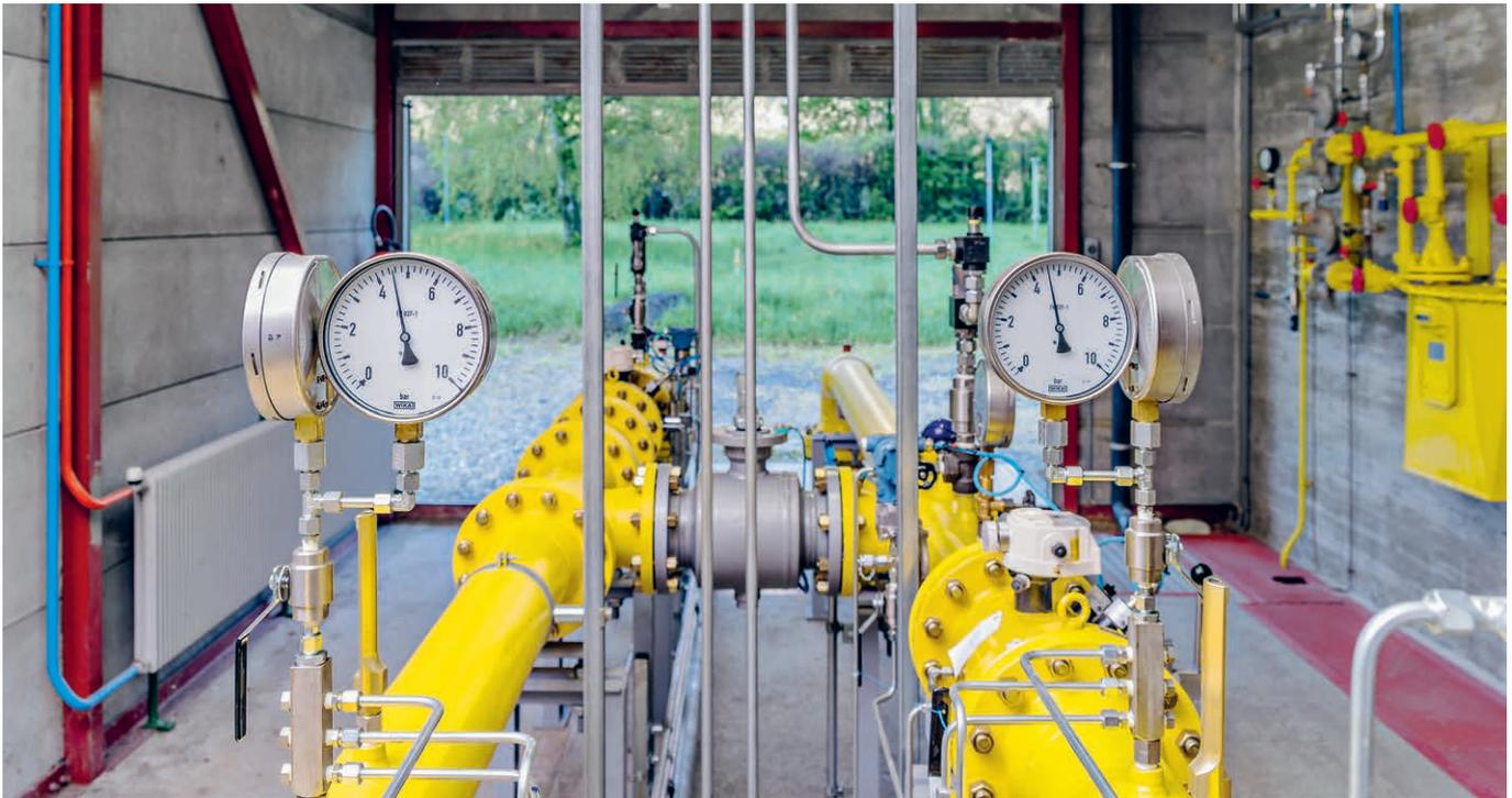
Le poste de détente et de comptage (PDC) de gaz naturel à Aigle permet de délivrer l'énergie à une pression réduite à la clientèle.
